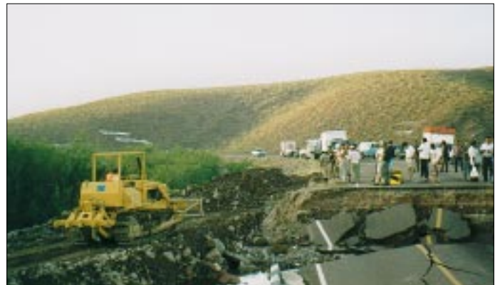
Erste Maßnahme: Zur Überbrückung der eingestürzten Straße wird eine Rampe zusammengeschoben.
